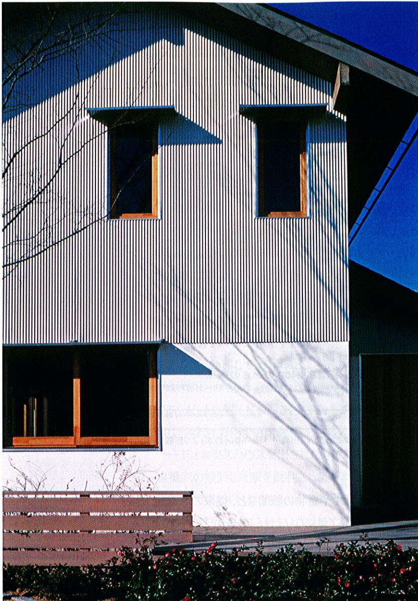
写真1 フォルクスハウス (撮影…北田英治)。外壁 上部はガルバリウム鋼板 小波、下部は窯業系サイ ディンググリシンかきおとし
